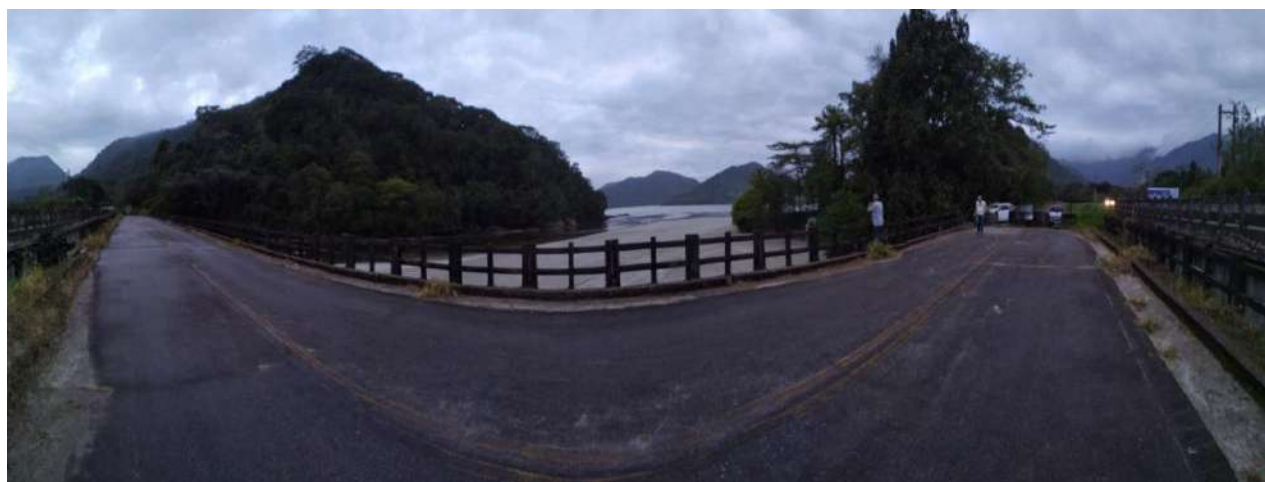
Foto 27 – Vista panorâmica da ponte existente no km 67,50
