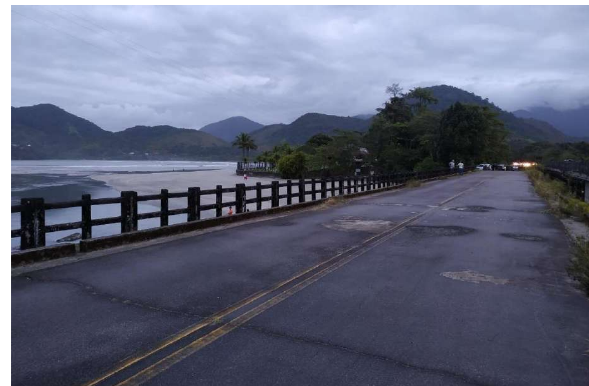
Foto 26 – Vista da ponte existente no km 67,50
