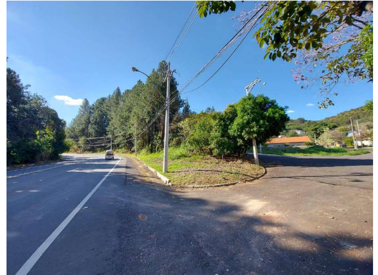
Foto 12 – Local de Implantação do paradouro da divisa. Tipo B
