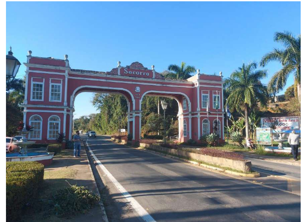
Foto 02 – PIT Portal Socorro vista frontal aproximada
