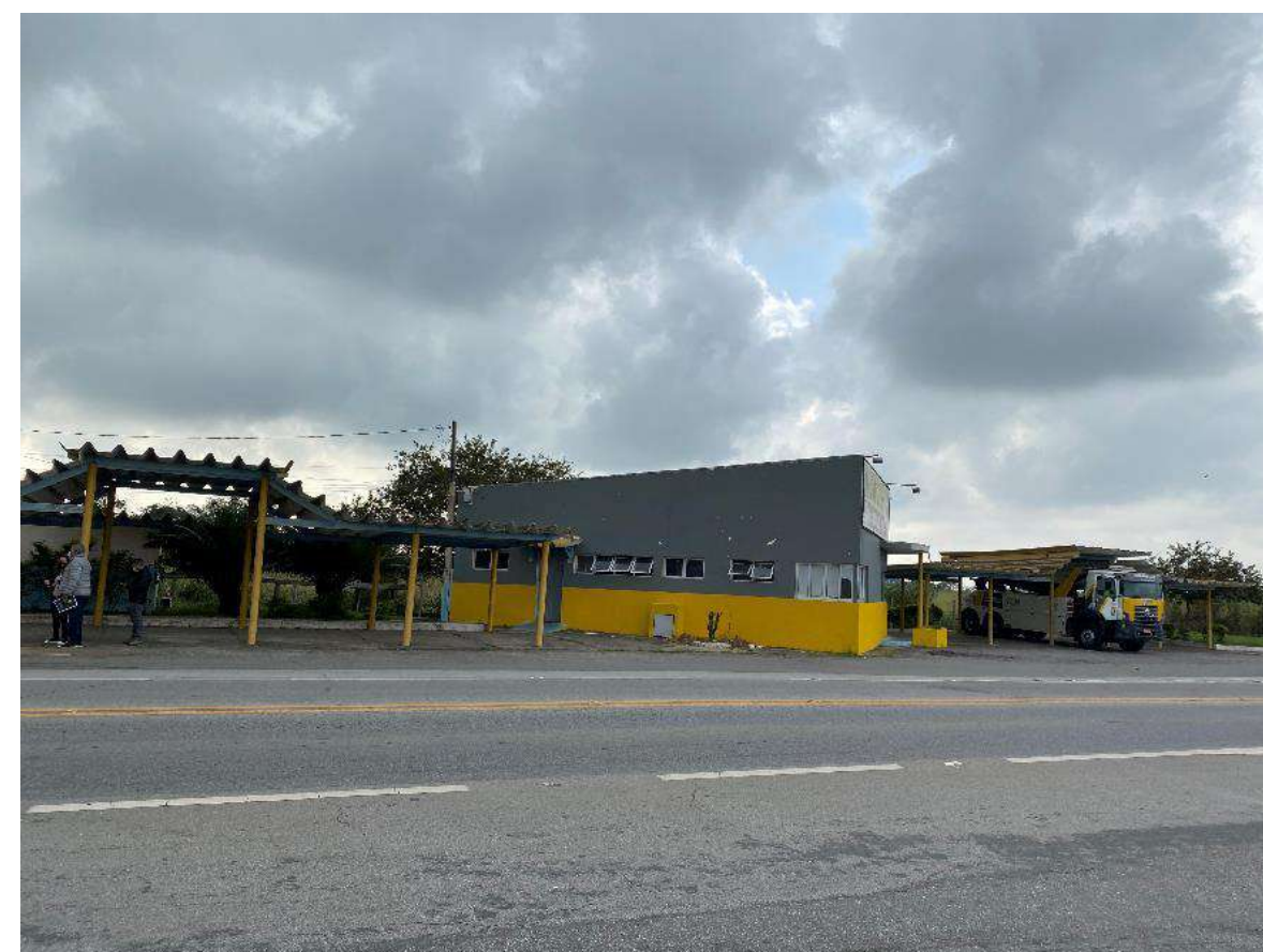
Foto 03 – Vista do Portal / PIT Posto DER
