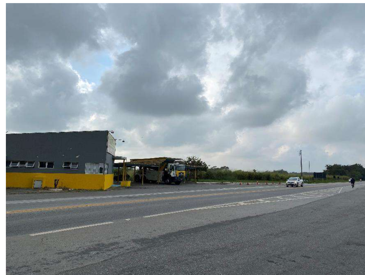
Foto 02 – Vista do Portal / PIT Posto DER
