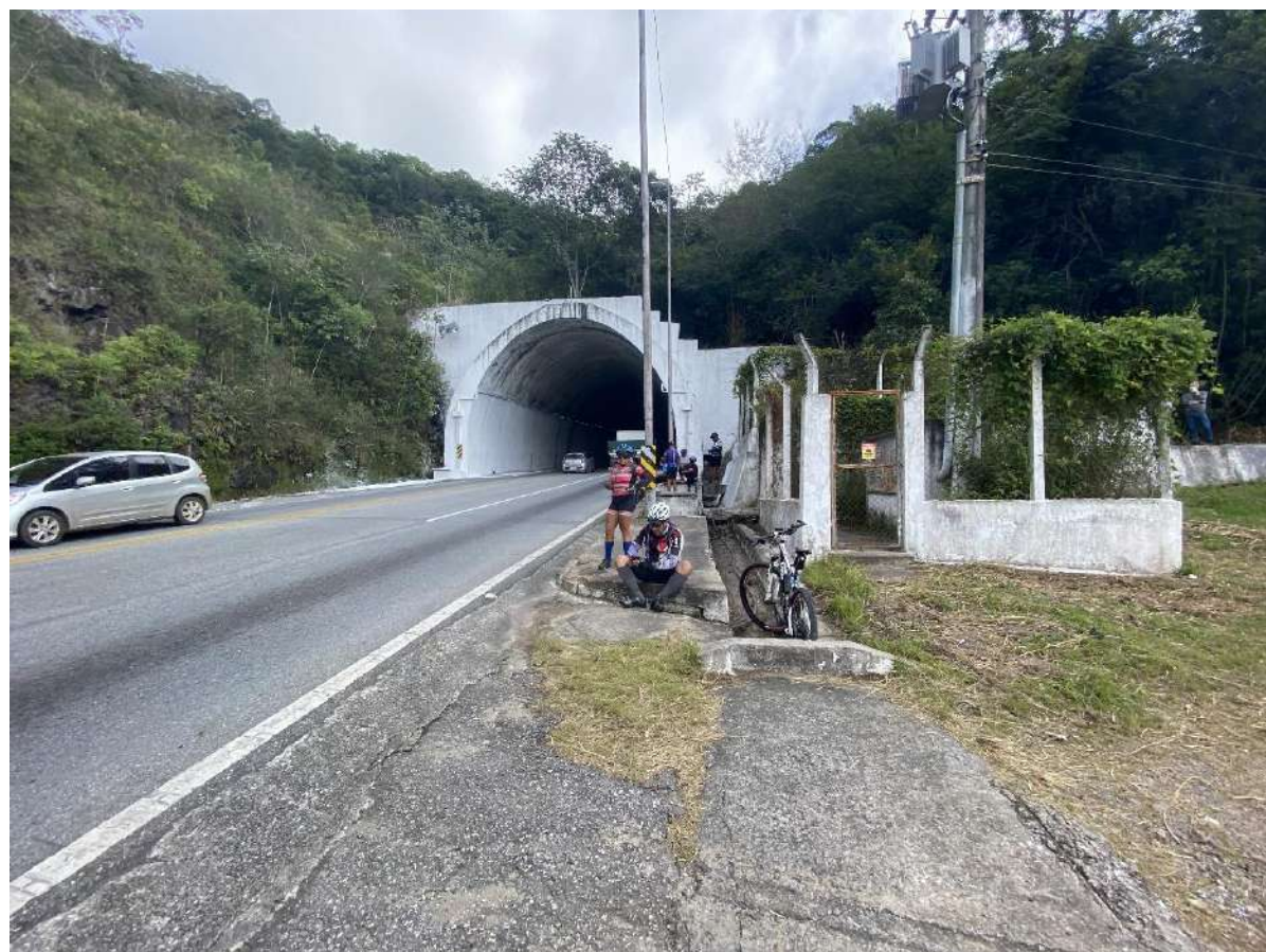
Foto 16 – Vista do Paradouro do Túnel
