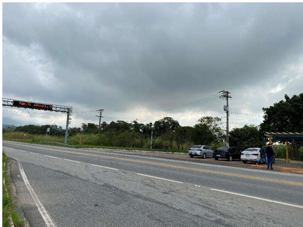
Foto 04 – Vista do Portal / PIT Posto DER
