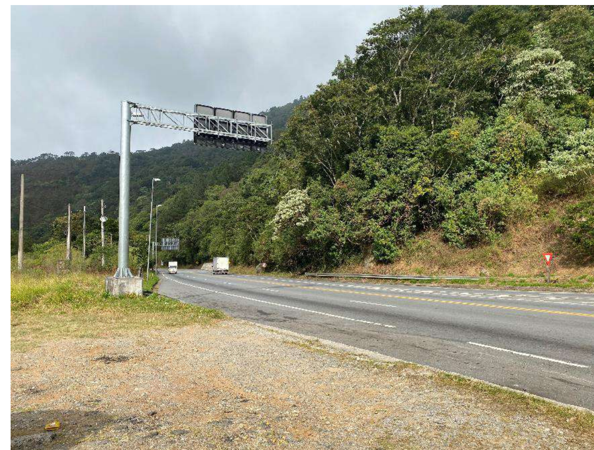
Foto 21 – Vista do Mirante do Viaduto
